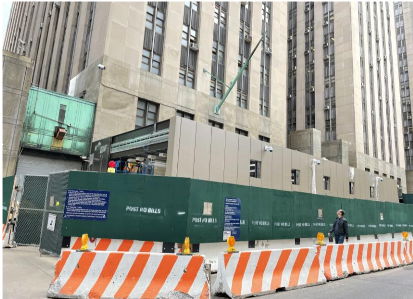
Interim Sally Port Construction 建設臨時安全通道 (5/10/2023)
