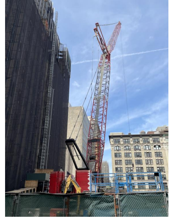
South Tower Crane 南樓起重機 (4/9/2024)
