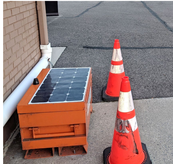
Monitoreo de vibraciones instalado afuera en la acera
